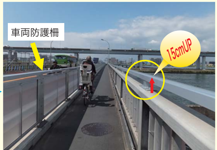
高欄が15cmかさ上げされた葛西橋通り下り線
