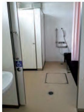
車いす用シャワー室
