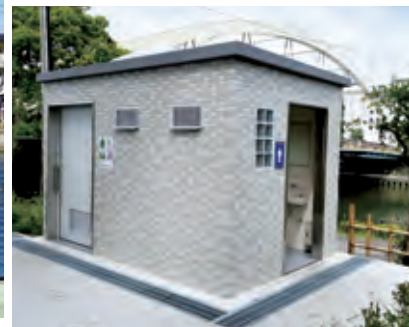
左近通り沿いの 公衆手洗所の改修完成
